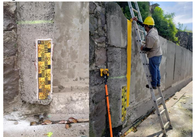
Figura 9. Colocación de referencia limnigráfica para la lectura del nivel durante las observaciones de tránsito de crecidas.
